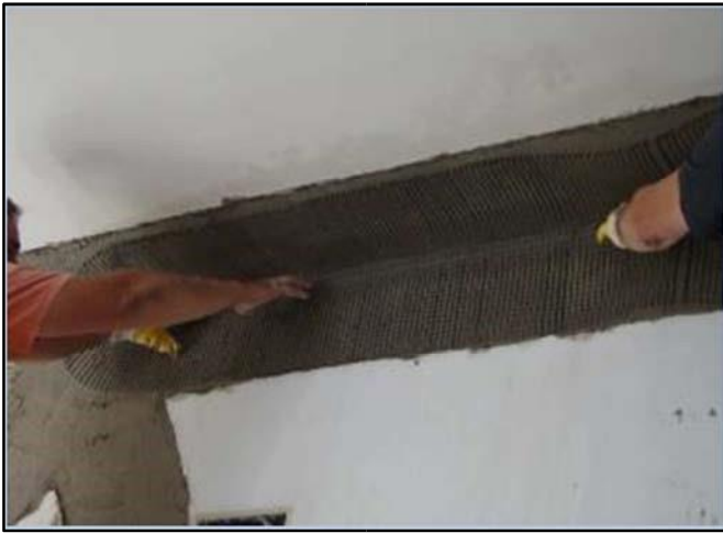
Figura 2.21 – Presidio antiribaltamento delle tamponature con diversi tipi di reti e connettori.
