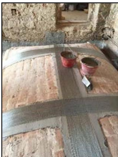
Figura 2.3 – Applicazione di fasce di tessuto metallico galvanizzato unidirezionale e malta per il rinforzo estradossale di volte murarie.
