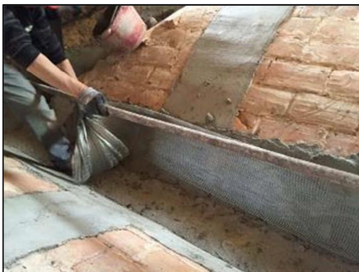
Figura 2.3 – Applicazione di fasce di tessuto metallico galvanizzato unidirezionale e malta per il rinforzo estradossale di volte murarie.
