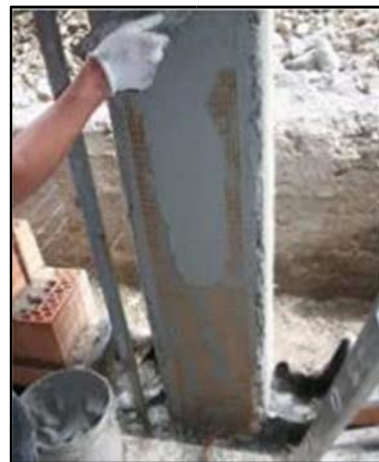
Figura 2.10 – Rinforzo flessionale di una trave e di un pilastro con rete di PBO.
