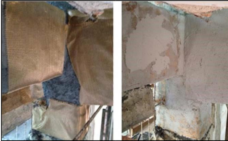
Figura 2.15 – Rinforzo di nodi travi-pilastro.
