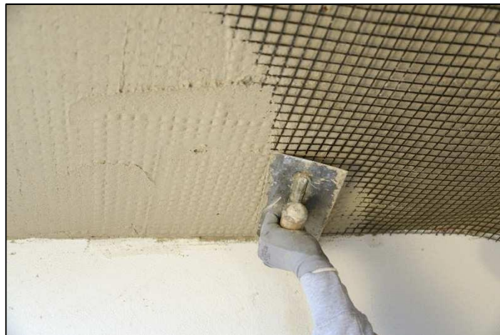
Figura 2.18 – Rinforzo di un solaio (antisfondellamento).
