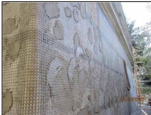
Figura 2.1 – Rinforzo di pannelli murari con rete di basalto.
