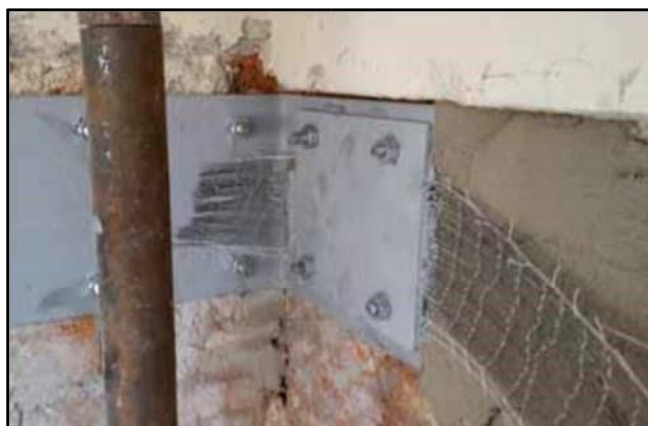
Figura 2.6 – Cordolature di piano realizzate con tessuti di PBO e acciaio.
