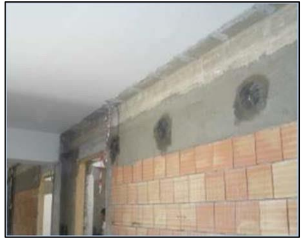
Figura 2.21 – Presidio antiribaltamento delle tamponature con diversi tipi di reti e connettori.
