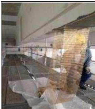
Figura 2.10 – Rinforzo flessionale di una trave e di un pilastro con rete di PBO.
