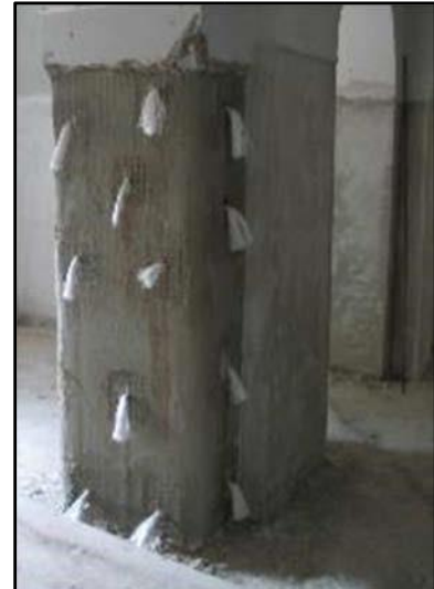
Figura 2.9 – Confinamento di pilastro di muratura con rete di vetro AR.
