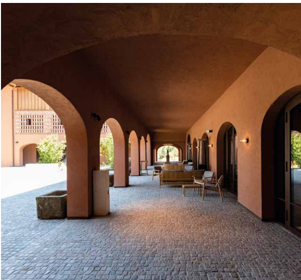
Casa di Langa - Cerretto Langhe (CN) webercote siloxcover M
